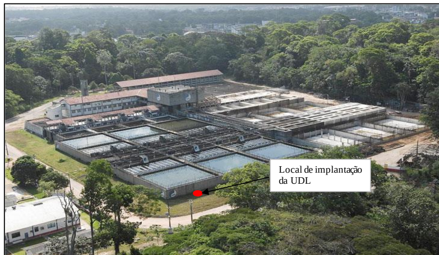
Figura 3.3– Vista panorâmica dos decantadores da ETA Bolonha. (GOOGLE EARTH, 2019)
