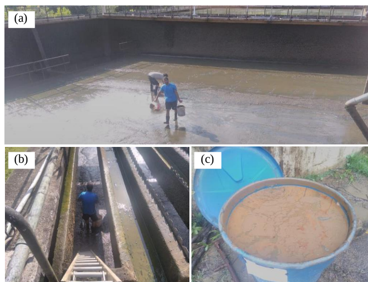
Figura 3.4 – Processo de coleta do lodo (a) ponto içamento do lodo; (b) UDL com lodo úmido; (c) raspagem do material e transporte até o ponto de içamento.
